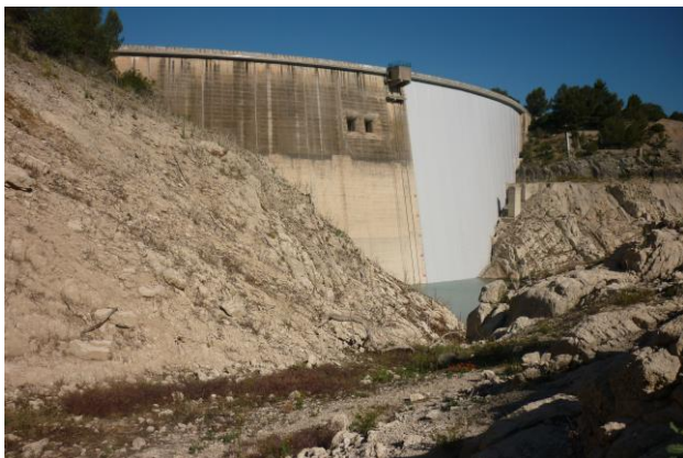
L'amont du barrage de Bimont avec, à droite, le revêtement composite
