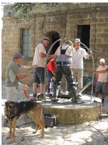
Descente de la pompe dans la citerne
