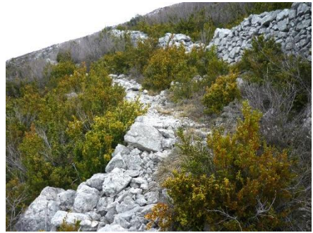
Le chemin construit sous l'enceinte nord
